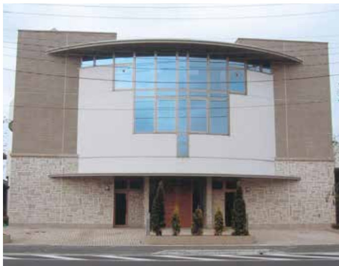
池羽レディースクリニック／西川産業一級建築士事務所
