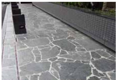
FRASER PLACE / 協立建築設計事務所
